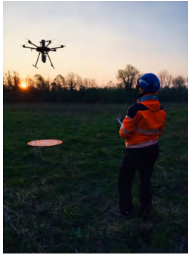
FIGURE 10.8. Drone et pilote sur le site
