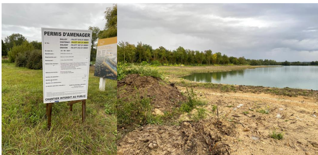
Figure 2. Projet de casier de surstockage : les premiers coups de pioche (photo réalisée en sept. 2022, J. Gobert).
