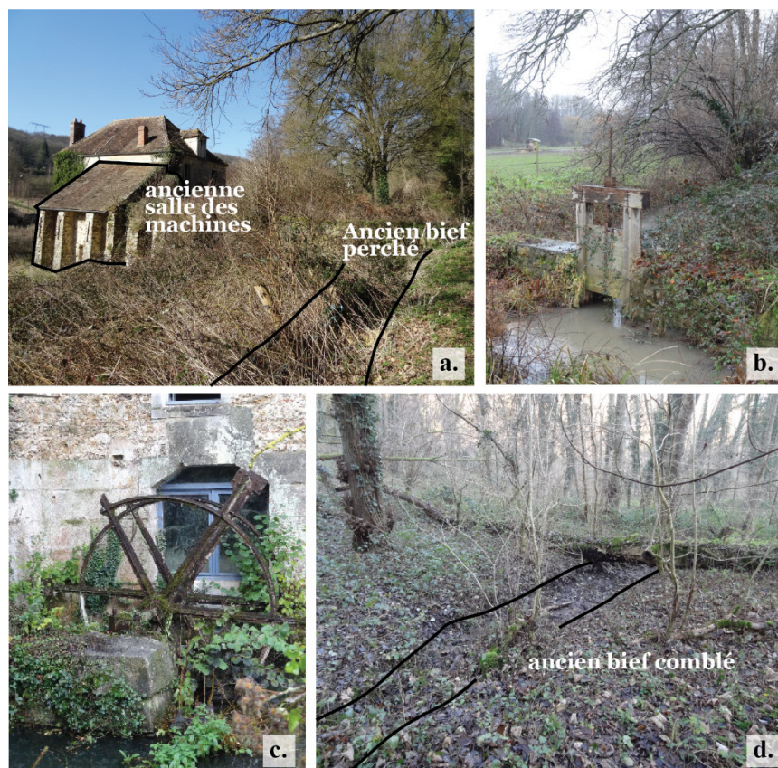
Figure 7 : Exemples de friches hydrauliques sur la Mérantaise. a. moulin des Vassaux abandonné ; on y aperçoit l'ancienne salle des machines et un ancien bief perché. b. ancienne vanne levée en amont du moulin de la Tuilerie (Aubert). c. ancienne roue du moulin d'Ors. d. ancien bief comblé entre le moulin d'Ors et le moulin des Vassaux, laissant une trace presque imperceptible de sa présence. (crédit photo : M. Jugie)
