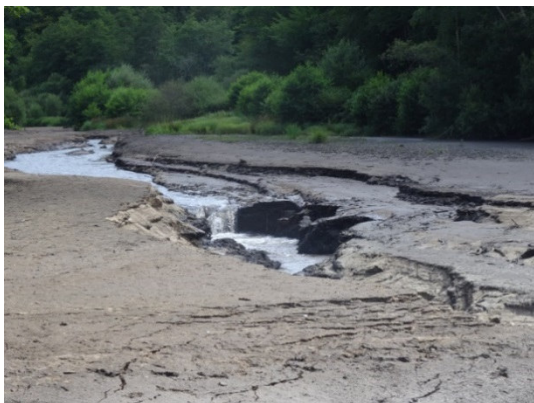
Figure 9 : Rupture de pente (« knickpoint ») indiquant le front d'érosion régressive remontant vers l'amont (photographie prise le 28/07/2015, 8 jours après le début de la vidange)
