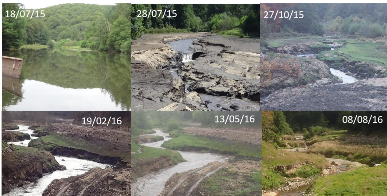
Figure 12 :Évolution du chenal en formation dans l’ancienne retenue de la Pierre-Glissotte (vue du barrage vers l’amont)
