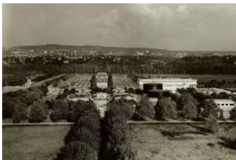
Figure 9. Station d'épuration d'Achères dans les années 1960 (Credit: Barles collection)
