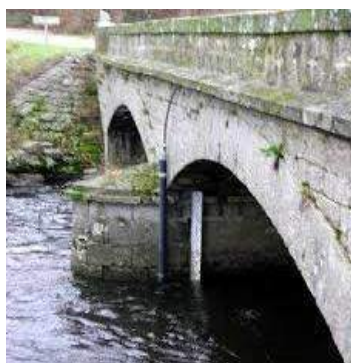
Station hydrométrique (DREAL)
