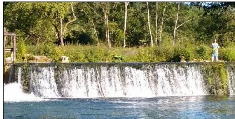
Barrage de Saucourt-sur-Rognon, 2016
