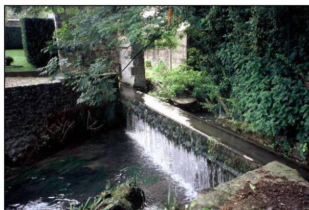
Le Pont-qui-Pleut, pont aqueduc permettant au rû des Auges de pénétrer dans la ville de Provins au-dessus du Durteint
