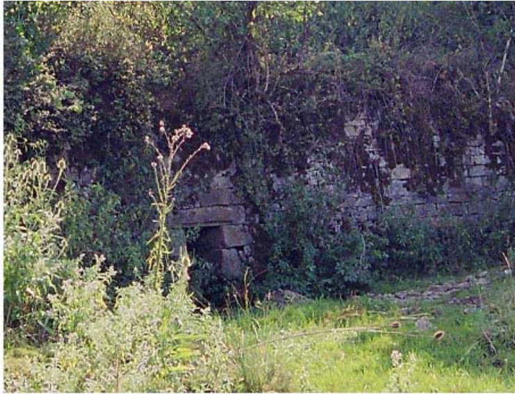
Sortie de l'eau après la chaussée. Nous remarquons les empièvements anciens.
