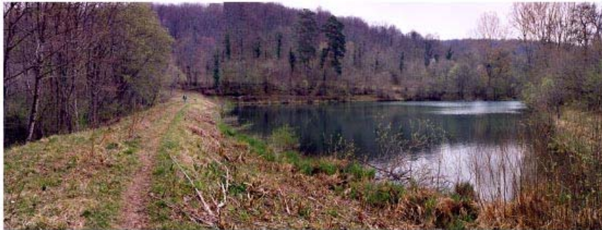
PHOTO N°6. VUE GENERALE DE LA CHAUSSEE ET DE L'ETANG VIEUX PROU
