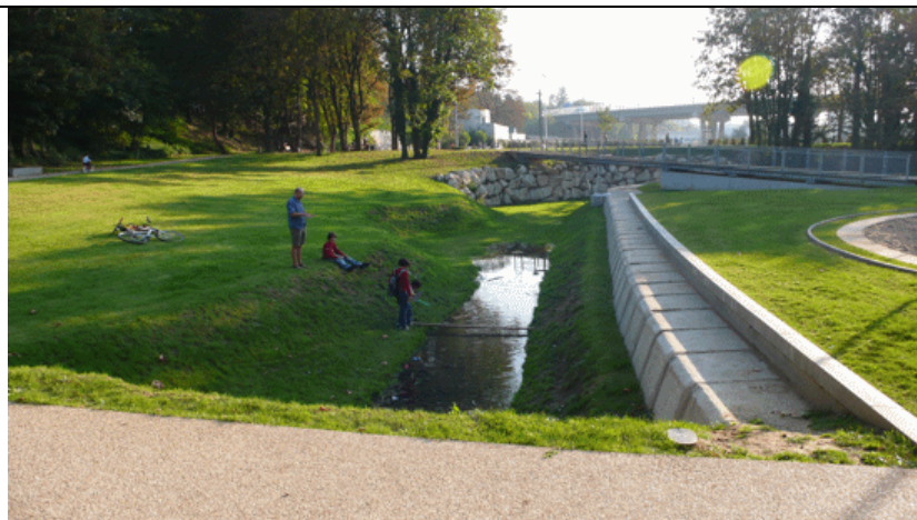
Figure 28 Canalisation traversant le stade Géo André
