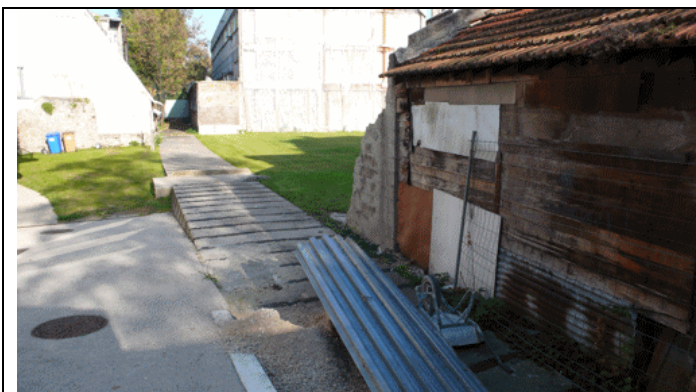
Figure 25 Traversée d'une cour intérieure de la rue Bouvery
