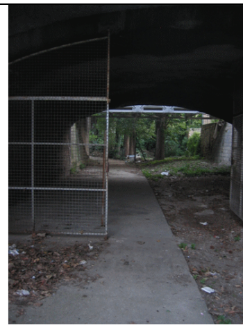
Figure 29 Passage sous l'avenue Doumer à Arcueil
