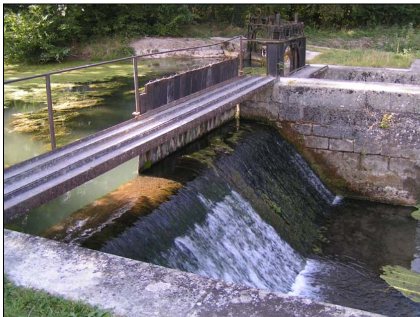
Figure 7 : Prise d'eau du canal de l'Aisne à la Marne à Sept-Saulx (photo O. Lejeune, 2004).
