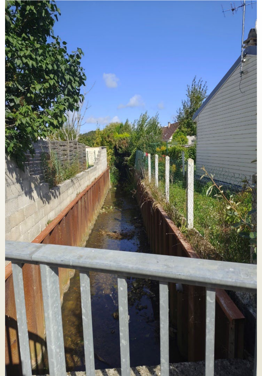
Ru d'Orgeval circulant entre des propriétés, enserré entre des palplanches, Orgeval © AR, 2025
