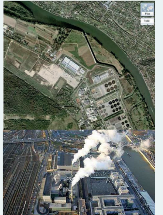
Station de traitement des eaux usées et incinérateur © Achères vue du ciel (Géoportail)
